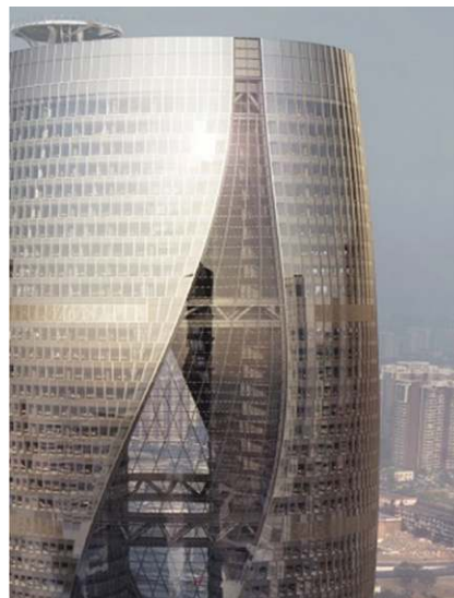
鱼鳞状幕墙和点式幕墙
